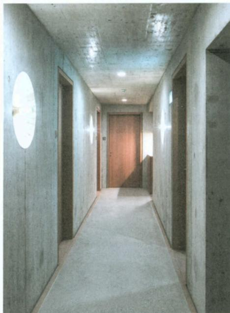
Der Korridor im neuen Hinterhaus. Indem der Boden rundum mit einer Leiste aus Eichenholz eingefasst wird, wirkt der Beton wie ein edler Läufer. Die Formen für die direkt in den Beton gegossenen Leuchenschirme fabrizierten die Architekten eigenhändig in ihrem Büro aus Styropor.
